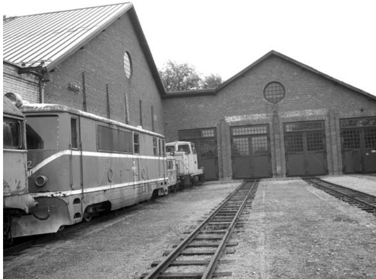
Panevėžio depe buvo remontuojami ir Biržų – Pasvalio ruožo riedmenys.
